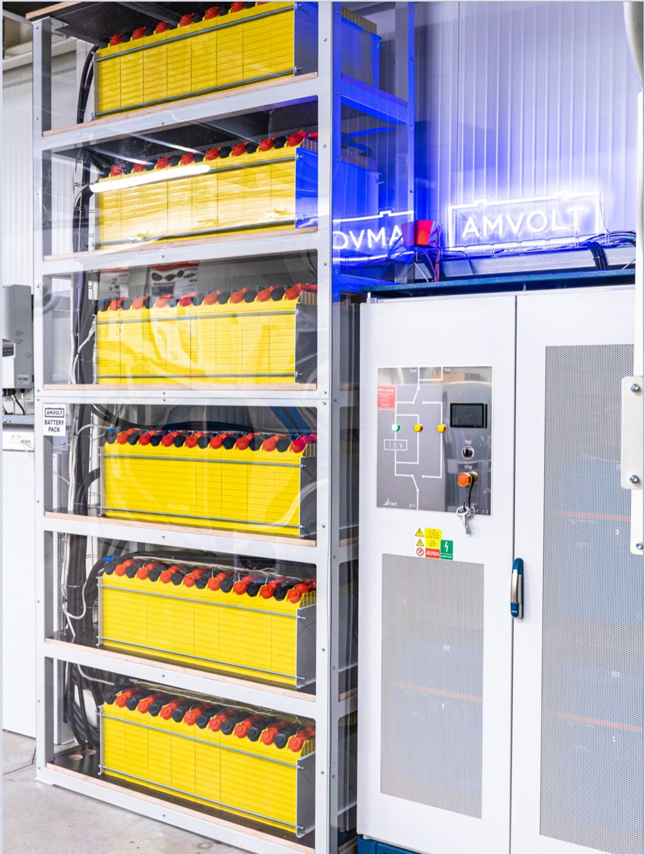
Obr.: Příklad rozměrově upravených AMVOLT 50kWh LV Modulů dle specifických prostorových možností zákazníka, partner realizace: Tomáš Vocilka (Asolar s.r.o.)
