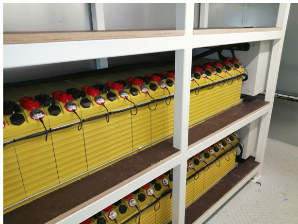
Obr.: 2x 16 kusů LiFePO 4 článků Winston 1000 Ah LiFePO 4 , 3.3 V s nominálním napětím 48 V a jejich výsledné umístění v AMVOLT Battery Containeru
