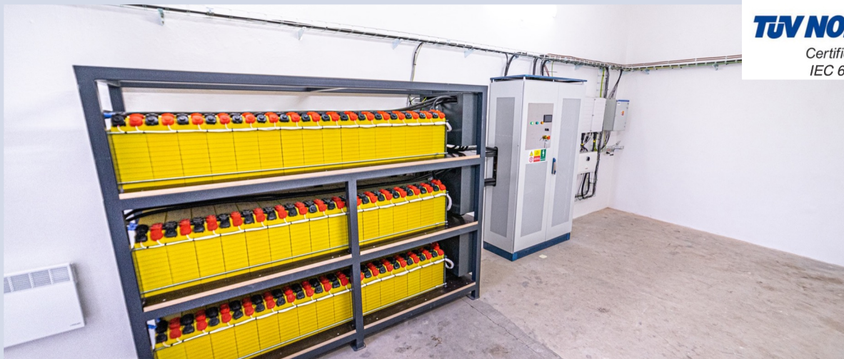
Obr.: 3x AMVOLT 50kWh Modul ve třech patrech nad sebou. 3x16 kusů LiFePO 4 článků Winston WB-LYP1000AHC 3.3 V, 1000 Ah s nominálním napětím 48 V, generální dodavatel instalace: ENER-SERVIS a.s. + Tomáš Vocilka (Asolar s.r.o.)
